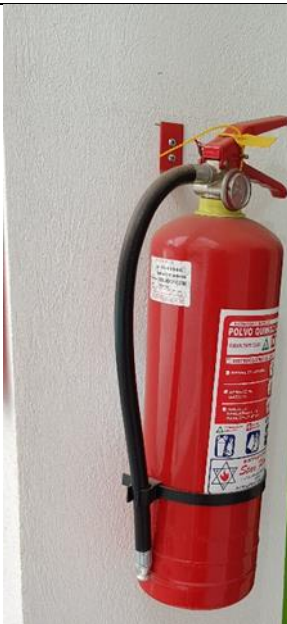
Extintor Nº2: exterior baño niveles medios
