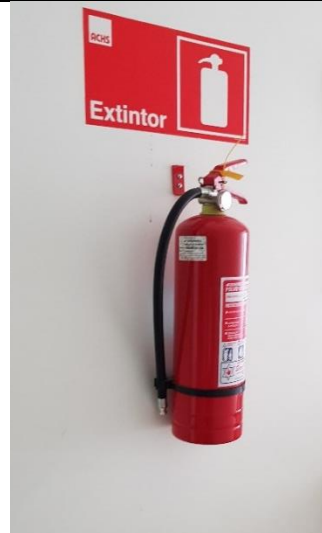
Extintor Nº1: pasillo Niveles medios
