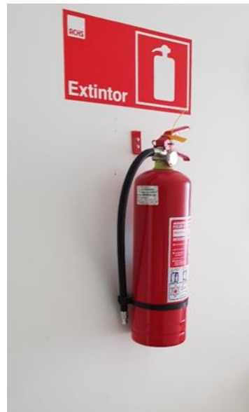
Extintor Nº3: exterior Sala Cuna
